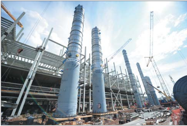
Рис. 6. Производство акриловой кислоты на ОАО «Газпром нефтехим Салават»
