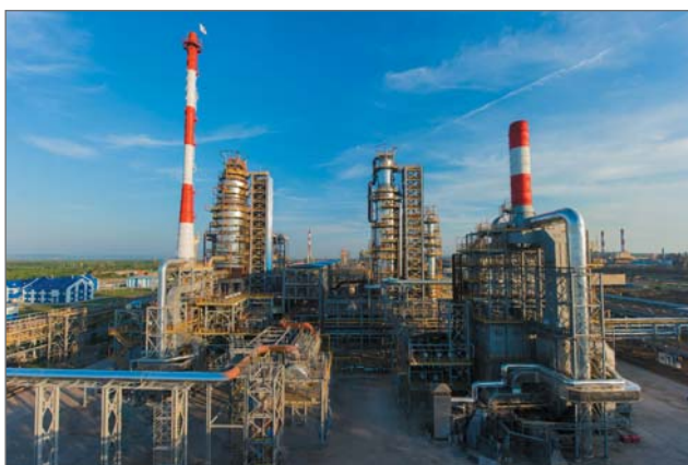
Рис. 2. Установка ЭЛОУ-АВТ-6 карбамида на ОАО «Газпром нефтехим Салават»
